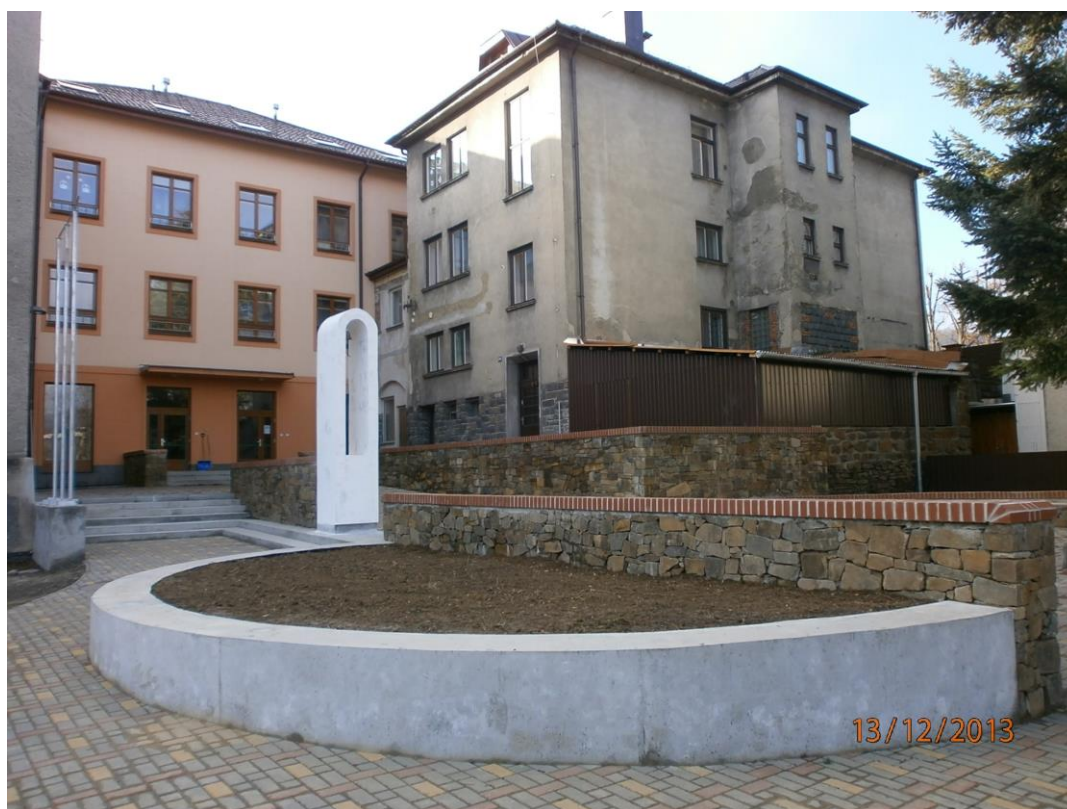
Podzim 2013 – budova tělocvičny před rekonstrukcí
