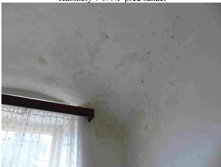
Kabinety v 1. NP před sanací
