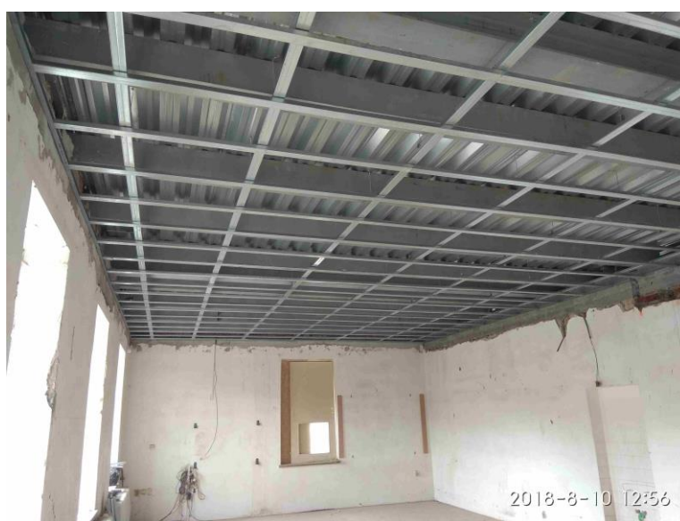
Výměna stropních konstrukcí
