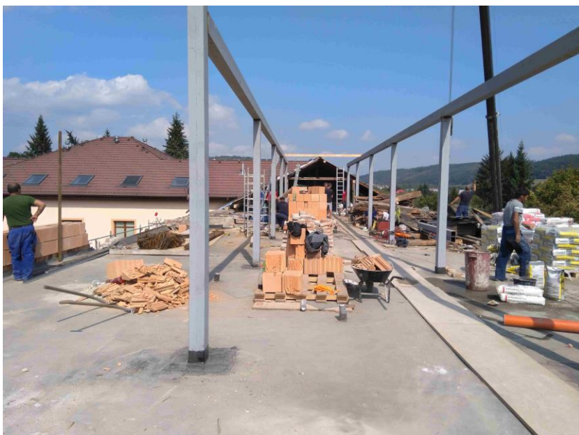
Rekonstrukce střechy, výstavba podkroví pro DM
