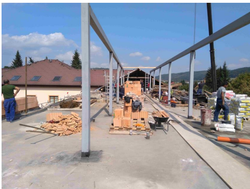
Rekonstrukce střechy, výstavba podkroví pro DM – srpen 2018
