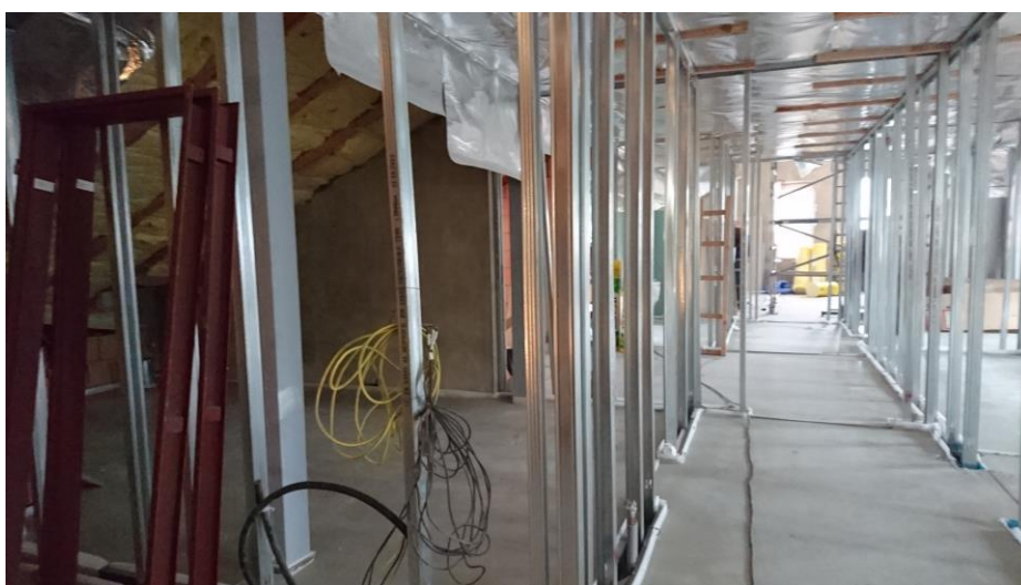
Vnitřní konstrukce, budoucí příčky
