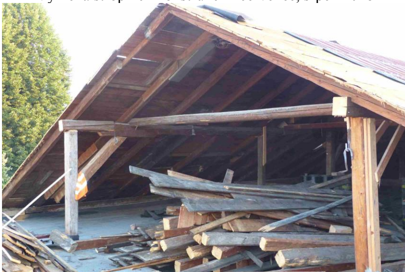
Výměna stropních konstrukcí – červenec, srpen 2018
